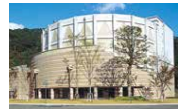
朝来市和田山ジュピターホール(JV) (朝来市)
