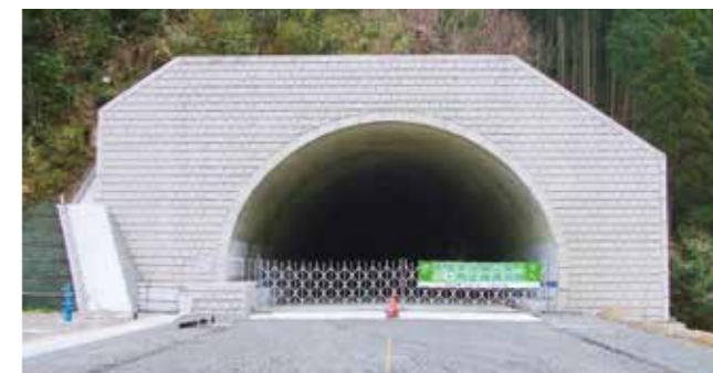
丹生地トンネル
