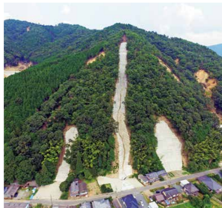
徳尾谷上地区急傾斜崩壊対策（丹波市）
